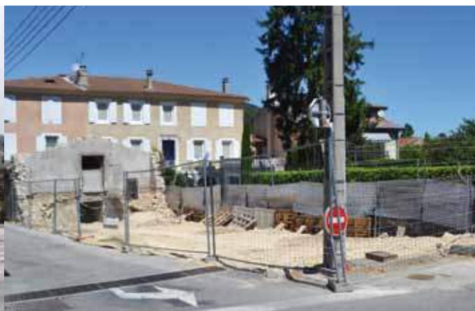
Démolition du garage Quai Bouvat.
